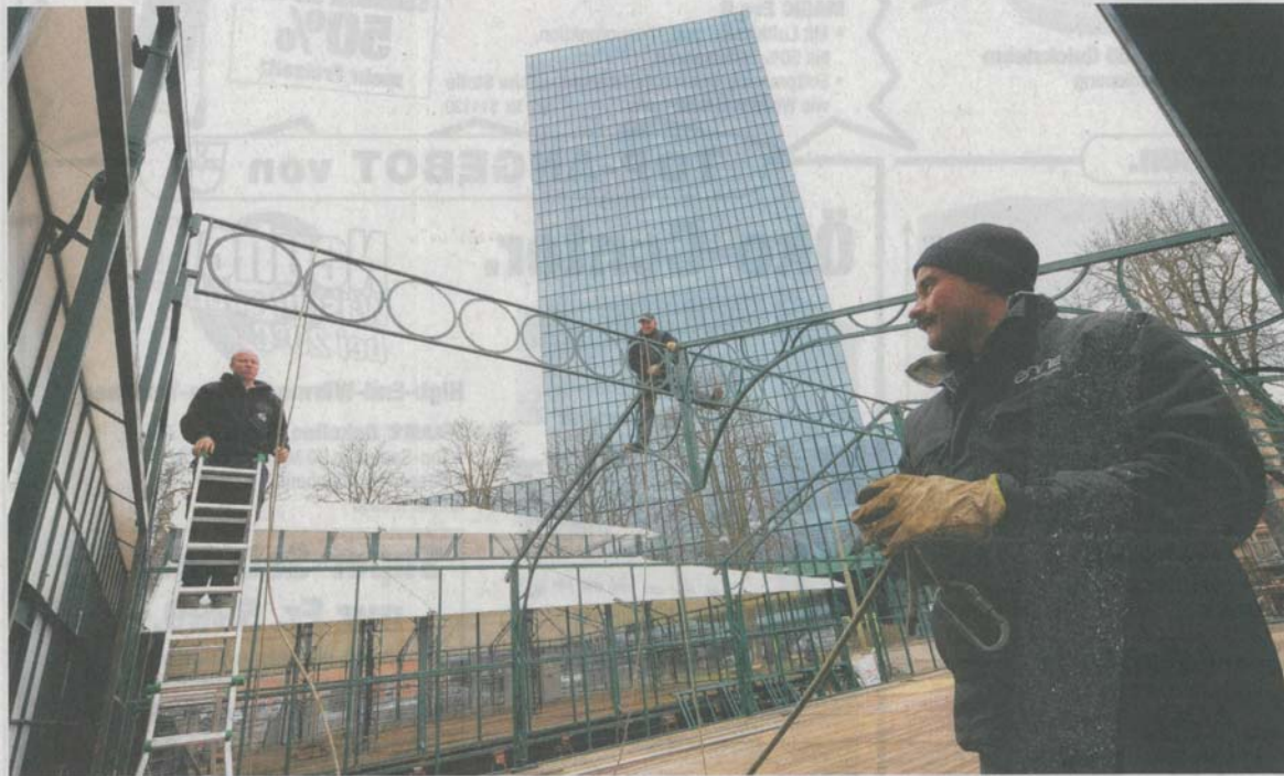
Im Aufbau. Auf der Rosentalanlage stellen Arbeiter einen Pavillon für die Baselworld auf. Foto Dominik Plüss
